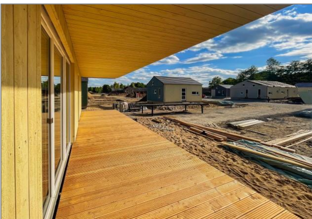
Fotos: Das KoDorf Wiesenburg in der Entstehung. Einblicke in die Baustelle. © Don Ludwig
