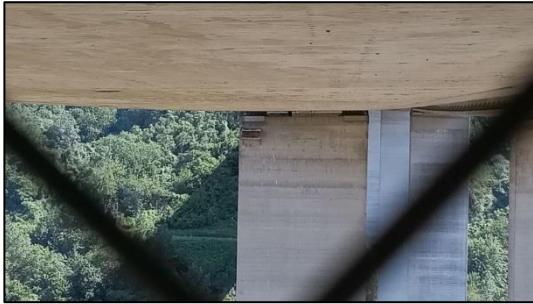
Abb. 5: Blick auf den Brutkasten der Wanderfalken an einem der Pfeiler
