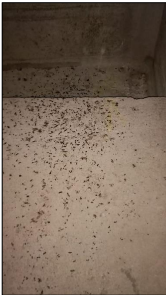
Abb. 17: Ansammlung von Kot in einem der Hohlkästen der Brücke. Aufgefunden während der Sommerbegehung.
