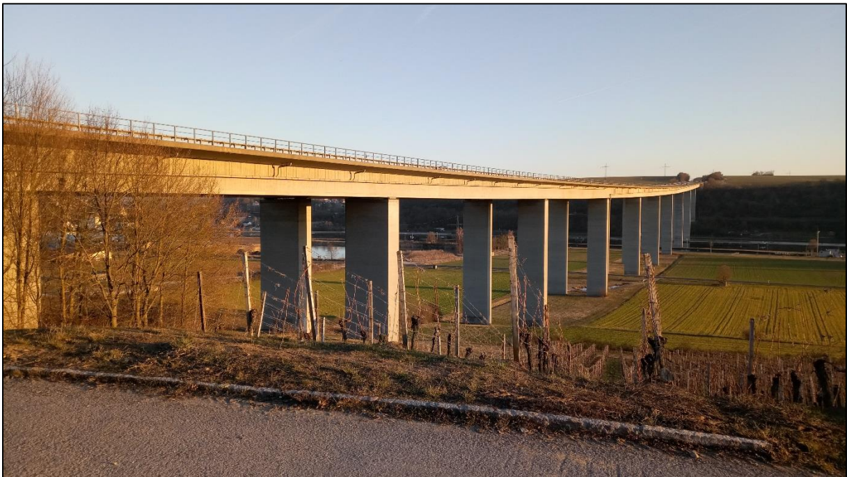
Abb. 1: Mainbrücke A7 Marktbreit mit Blick in Richtung Süden
