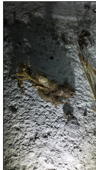
Abb. 18: Skelett einer Fledermaus (vermutlich großes Mausohr). Aufgefunden in einem der Pfeiler während der Sommerbegehung.
