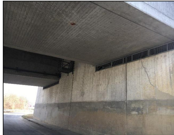
Abb. 13: Außenansicht des südlichen Widerlagers
