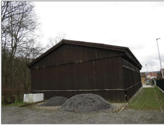
Abb. 2: Teilansicht der Nordwest- sowie Südwestseite des Gebäudes
