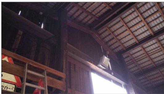
Abbildung 6: Eingangsbereich / Dach des Gebäudes
