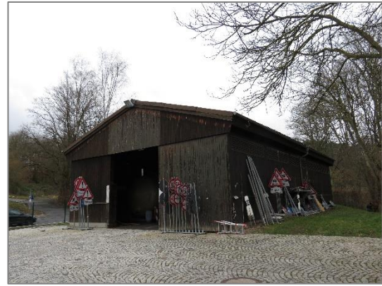
Abb. 3: Teilansicht der Nordost- sowie Südostseite des Gebäudes
