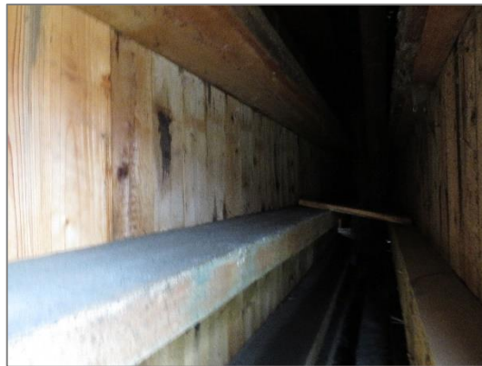
Abbildung 5: Innenansicht der doppelten Verschalung des Gebäudes
