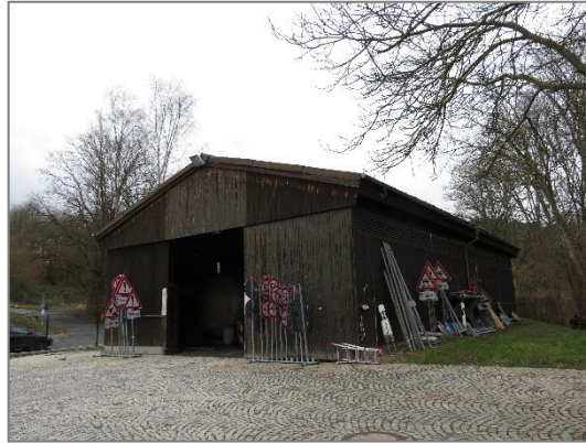
Abbildung 3: Teilansicht der Nordost- sowie Südostseite des Gebäudes
