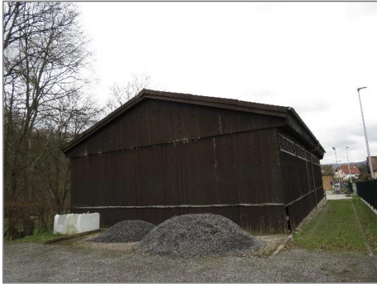
Abbildung 2: Teilansicht der Nordwest- sowie Südwestseite des Gebäudes
