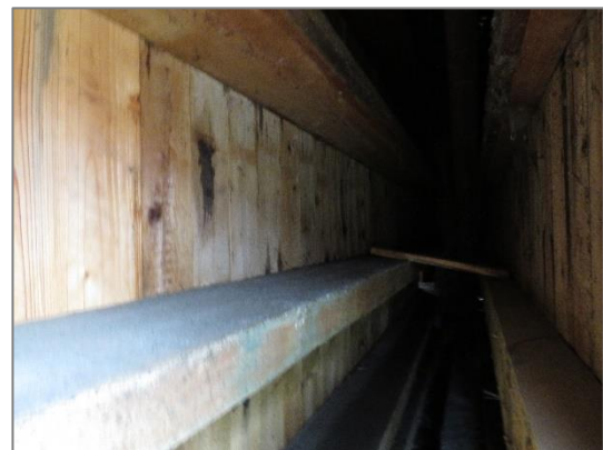
Abb. 5: Innenansicht der doppelten Verschalung des Gebäudes
